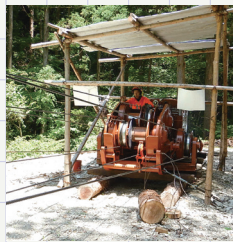
④無線を頼りに集材機の4つのドラムから出ているワイヤーを操作し宙吊りにした木材を移動させる
