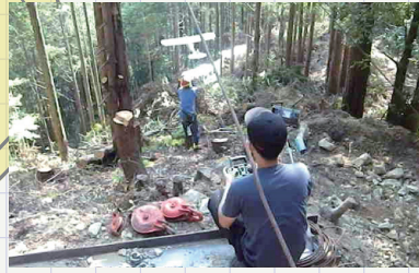
①本線が谷をまたぐ時の一番最初はラジコン飛行機に軽いバンダーひもを付けて向かいの山頂まで飛ばし、滑車を使って徐々にひもをため最後に何トンもある本線につなげる。
